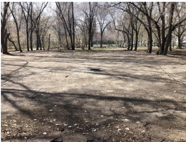
Рисунок 18 – Существующее асфальтовое покрытие
