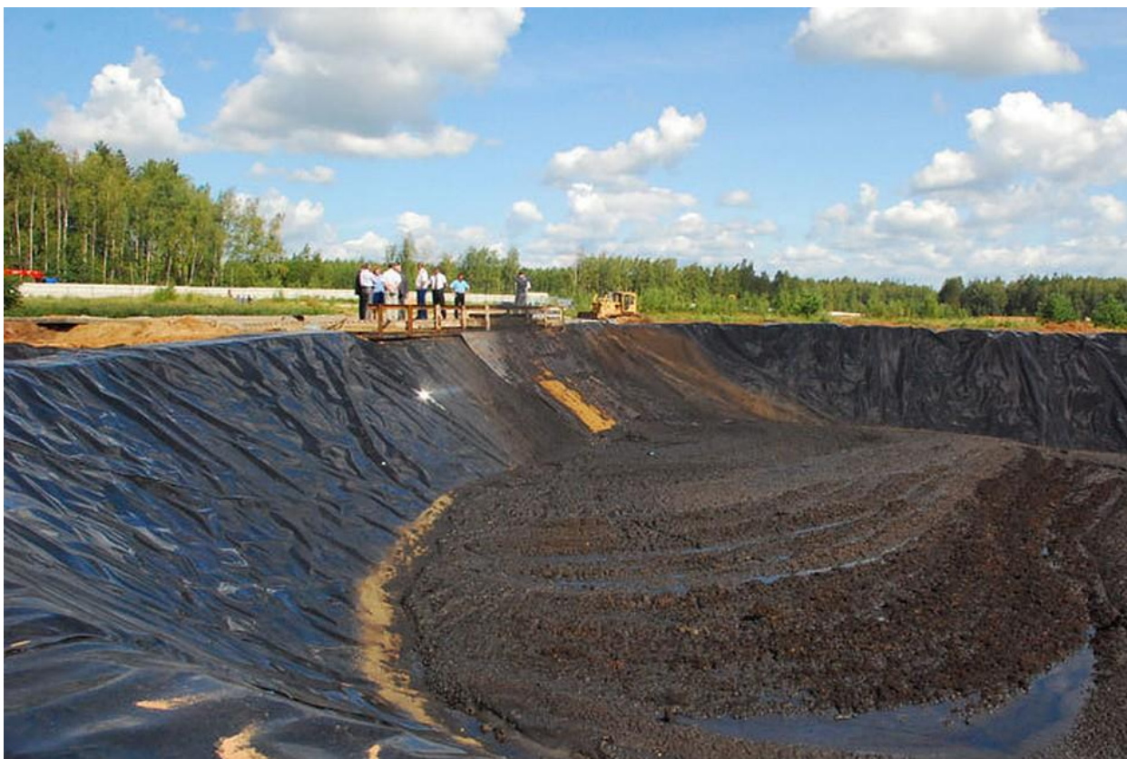
Рисунок 8 – Временное хранение шлама бурового в ТПП «ПОВХНЕФТЕГАЗ»
