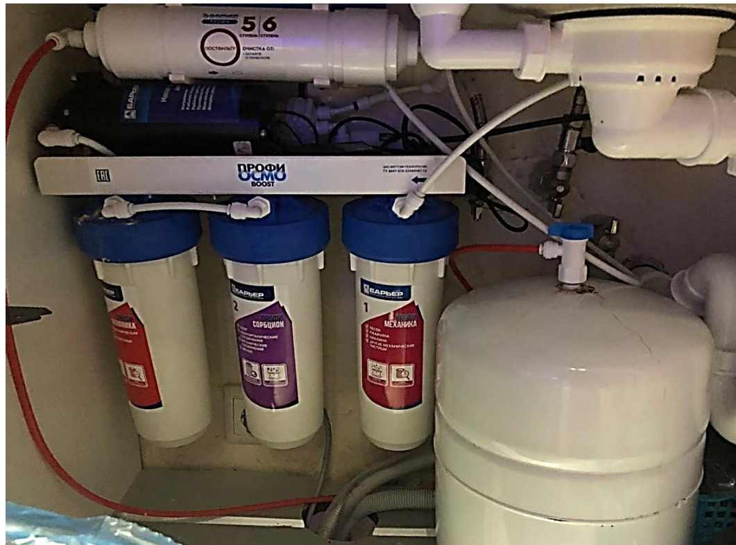
Рисунок 11 – Система обратного осмоса в индивидуальном жилом доме
