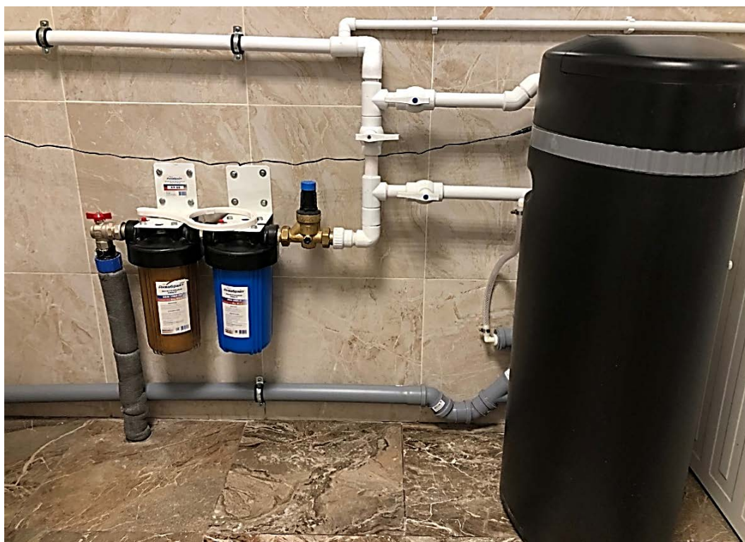
Рисунок 10 – Доочистка воды в индивидуальном жилом доме
