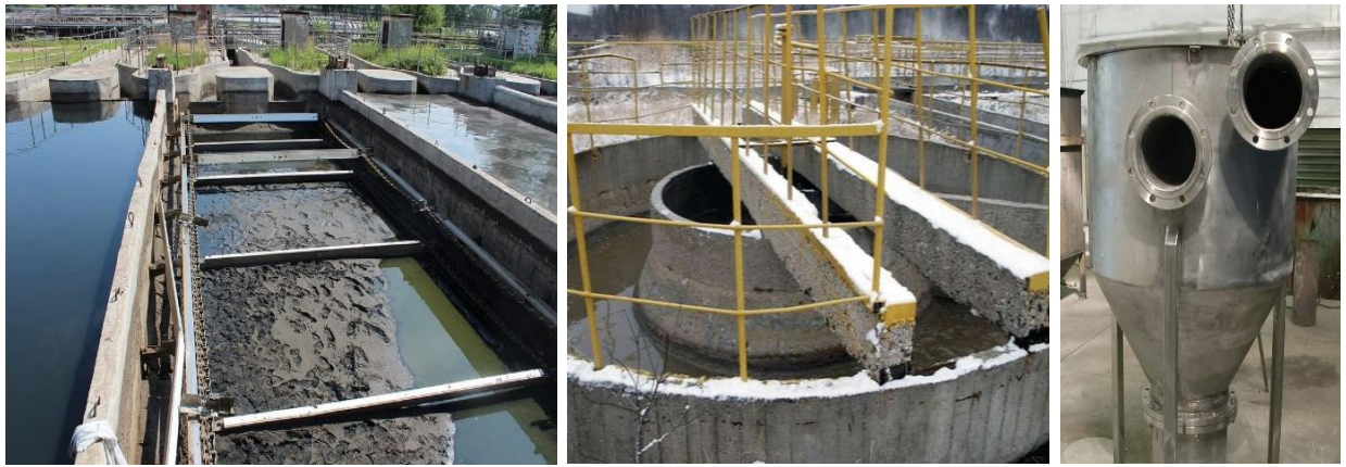
Рисунок 4 – песколовки (слева-направо – горизонтальные, с вертикально-поступательным (винтовым) движением, тангенциальные)
