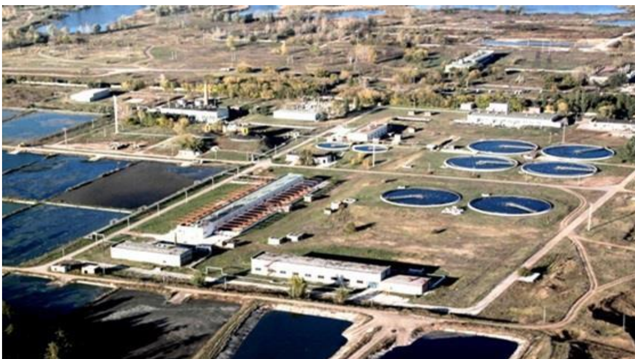
Рисунок 10 – Общий вид очистных сооружений канализации
