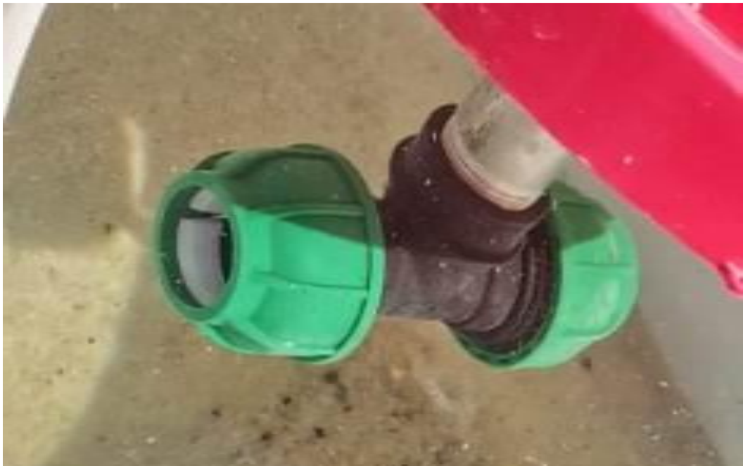
Рисунок 34 – Верхнее распределительное устройство исследуемого песчаного фильтра
