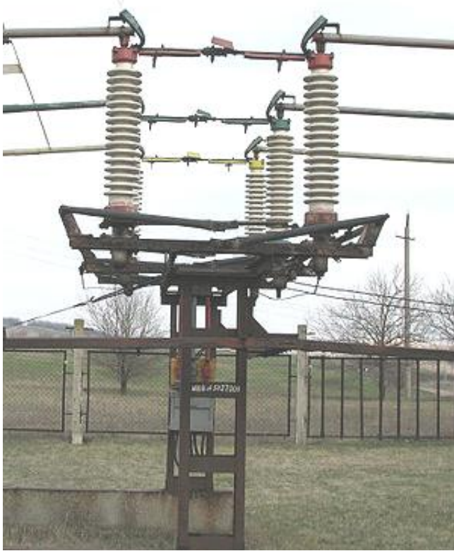
Рисунок 2 – Разъединитель марки РНДЗ-2-110/630
