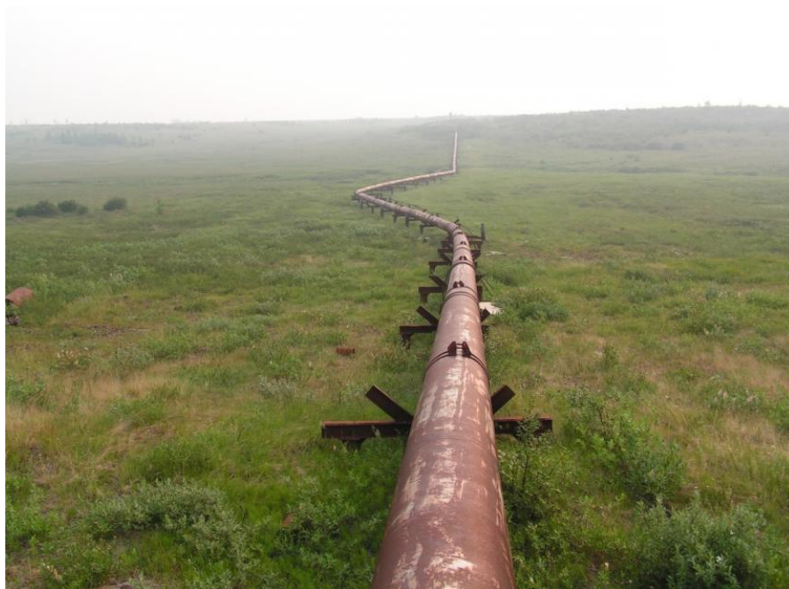
Рисунок 6 – Наземная прокладка трубопровода
