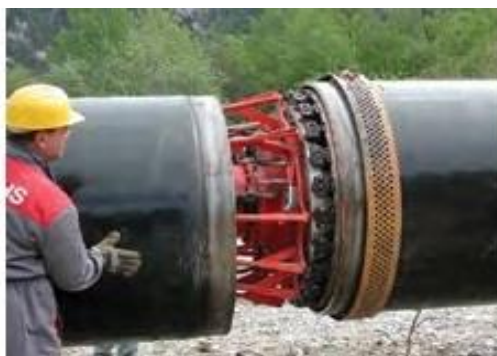
Рисунок 14 – Сборка труб на внутреннем центраторе
