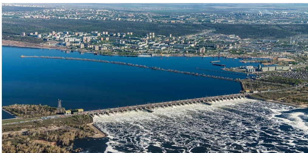
Рисунок 1 – Вид с воздуха на Жигулевскую ГЭС
