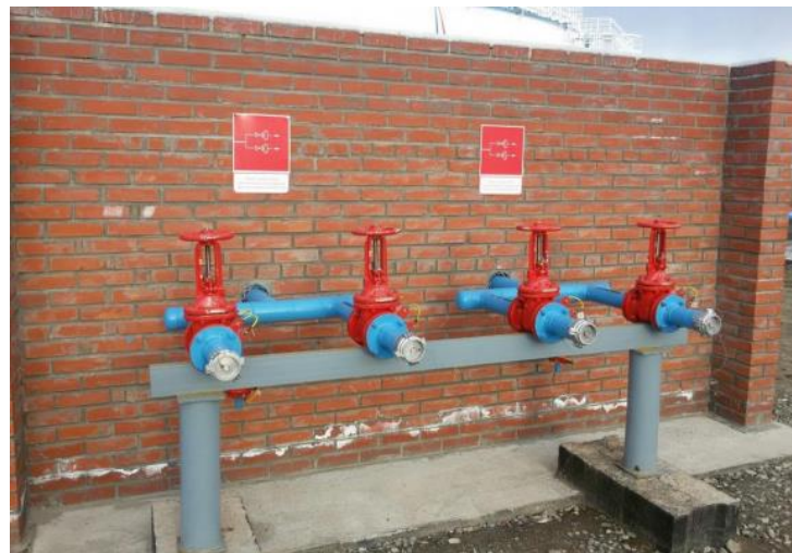
Рисунок 4 – Узел подключения водяного охлаждения ЛПДС «Самара»
