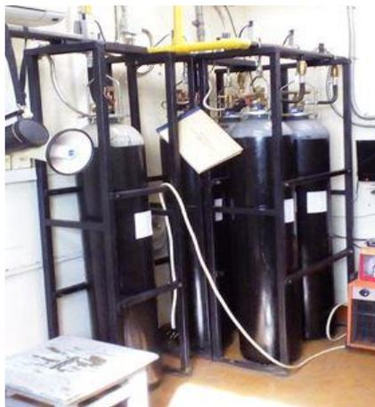
Рисунок 31 – Модули пожаротушения
