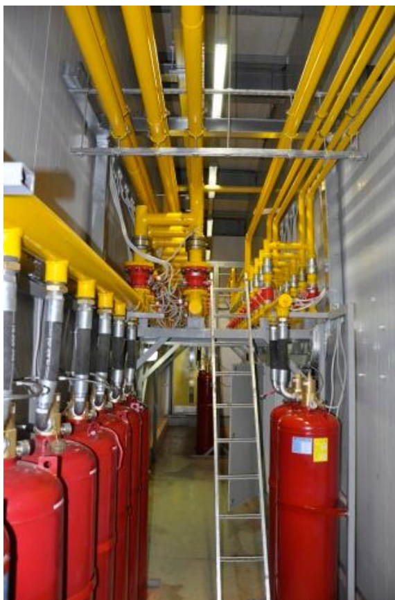
Рисунок 2 – Пример монтажа установки газового пожаротушения с применением Noves 1230 на предприятии
