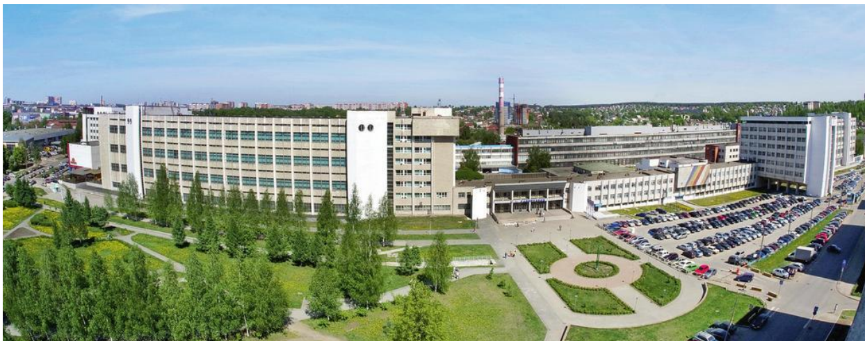
Рисунок 5 – Здание АО «Ижевский радиозавод»
