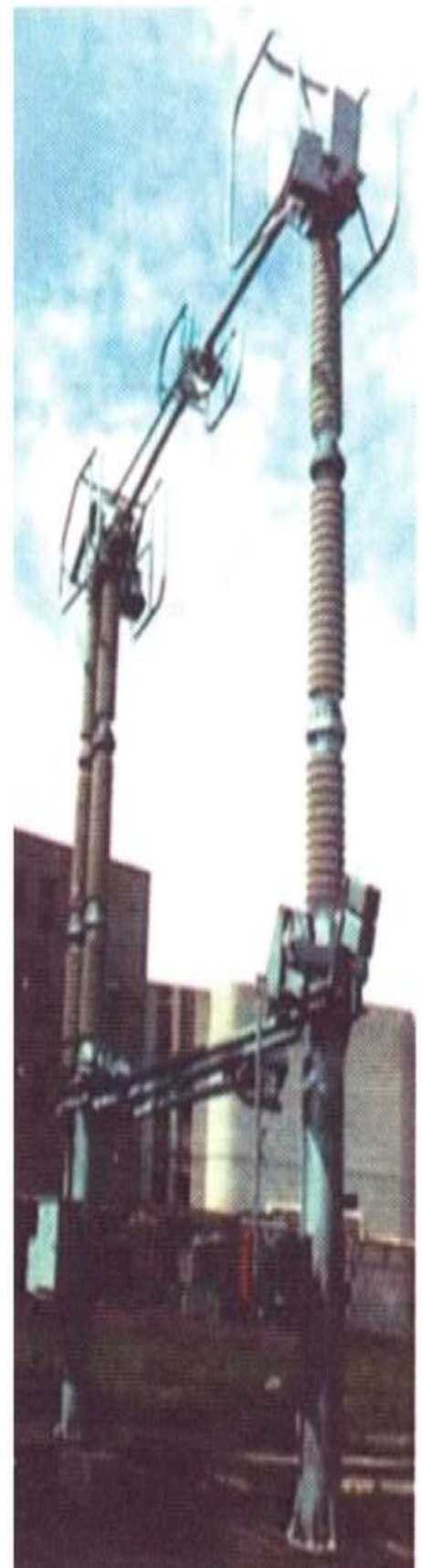
Рисунок 3 - Разъединитель однополюсный полупантографный типа РПГ
