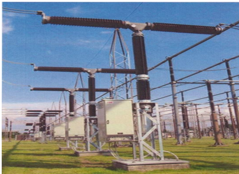
Рисунок 2 - Выключатель элегазовый колонковый марки HPL 550B2
