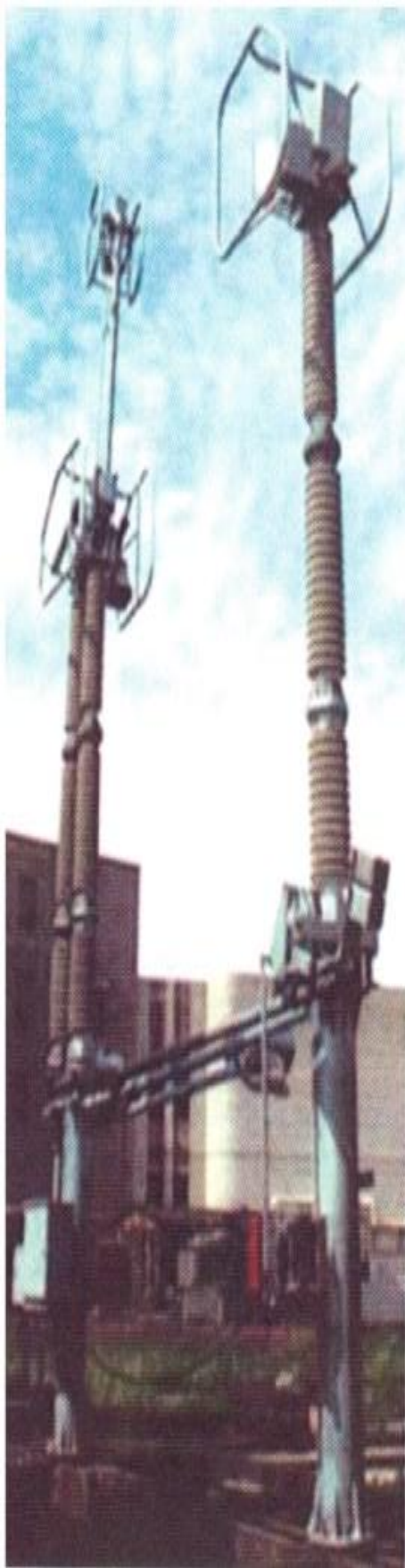
Рисунок 3 - Разъединитель однополюсный полупантографный типа РПГ
