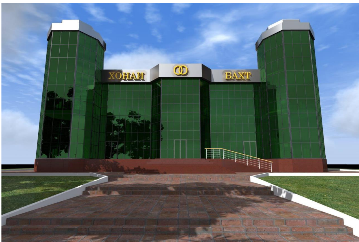
Рисунок 1 - Изображение центрального фасада дома бракосочетаний после реконструкции
