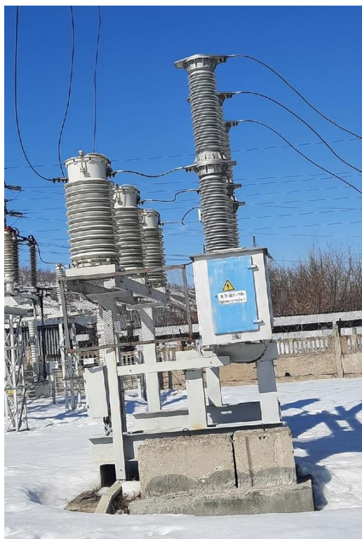
Рисунок 31 – Совместная установка ВГТ и ТФЗМ
