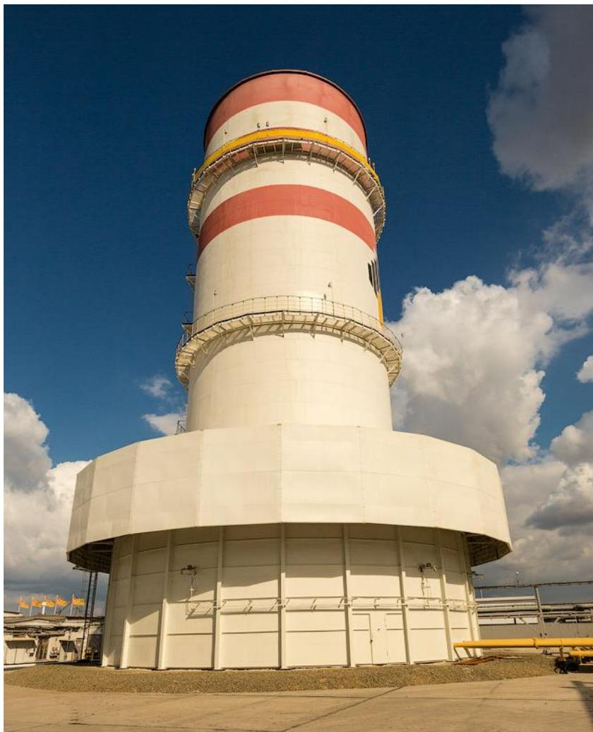
Рисунок 3 – Закрытая факельная система
