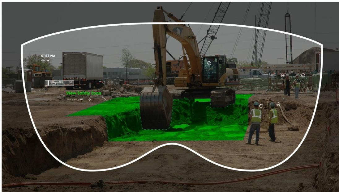
Рисунок 9 – Пример передачи элементов (опасных зон) дополненной реальности на очки работника
