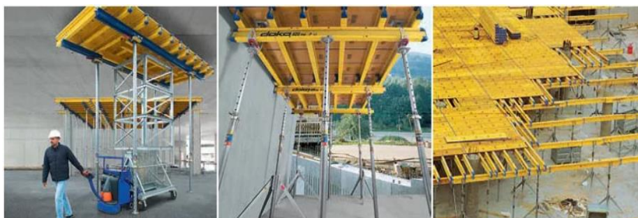
Рисунок 3.2 – Монтаж опалубки Dokaflex
