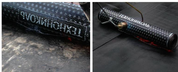
Рисунок 21 – Валик расплавленного битумно–полимерного вяжущего
