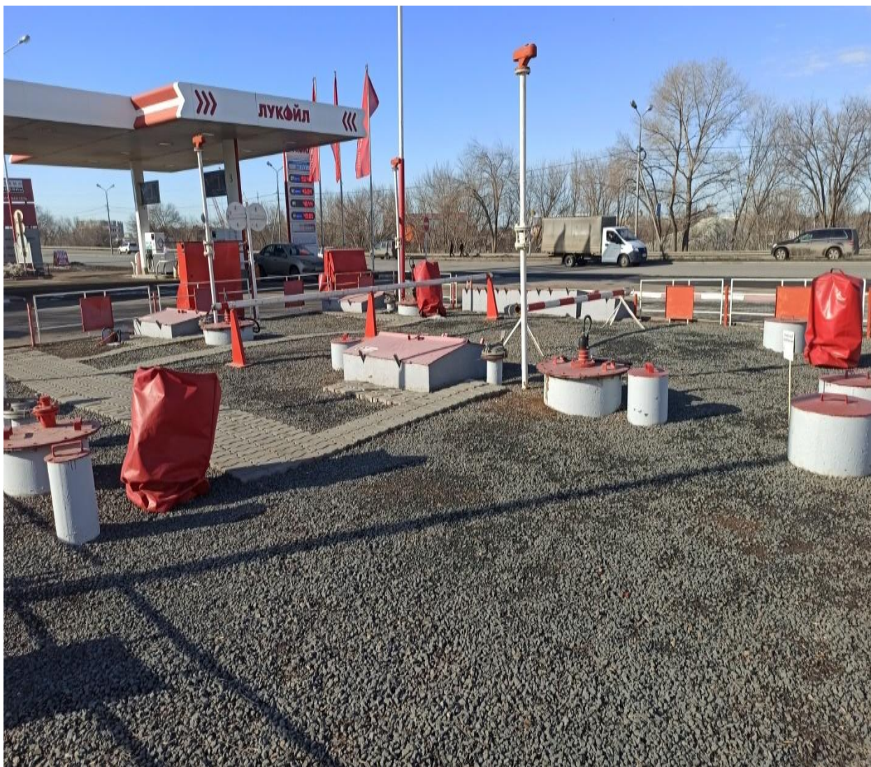
Рисунок 3 Территория резервуарного парка автозаправочной станции № 56048 ООО «ЛУКОЙЛ-Уралнефтепродукт».
