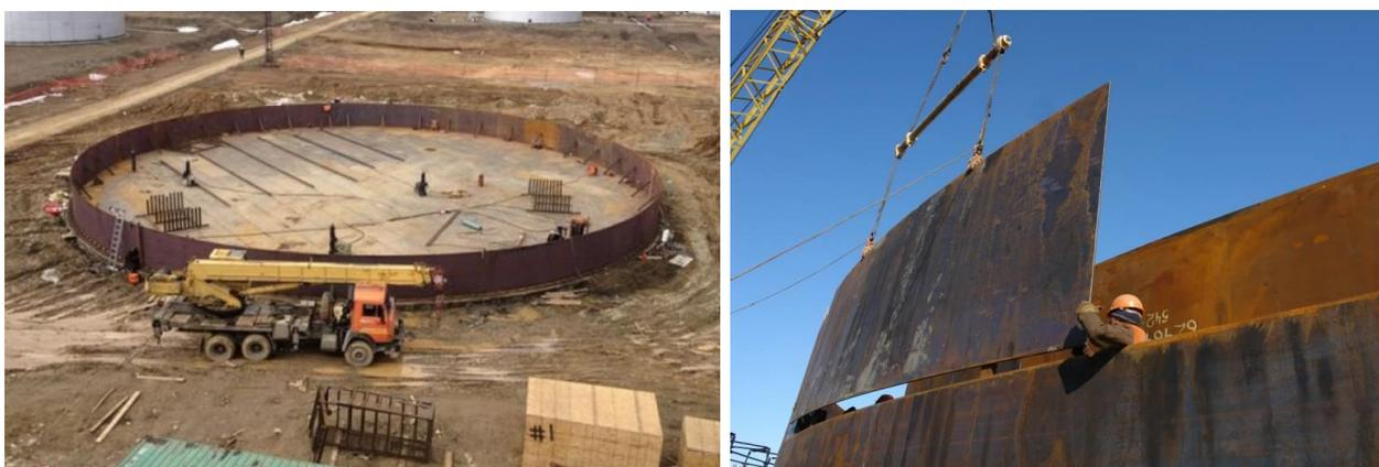
Рисунок 3 – Возведение резервуара полистовым методом (метод наращивания)
