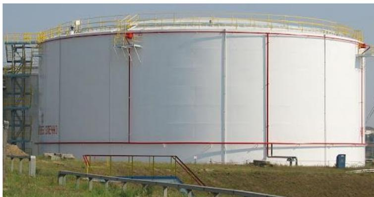
Рисунок 2 – Внешний вид резервуара РВСП-20000
