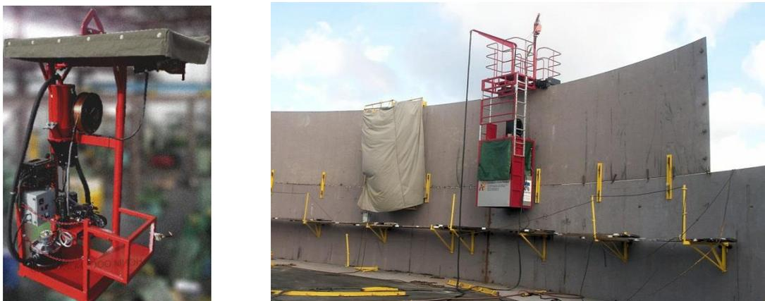
Рисунок 10 – Сварка горизонтального стыка с использованием установки AGW-I
