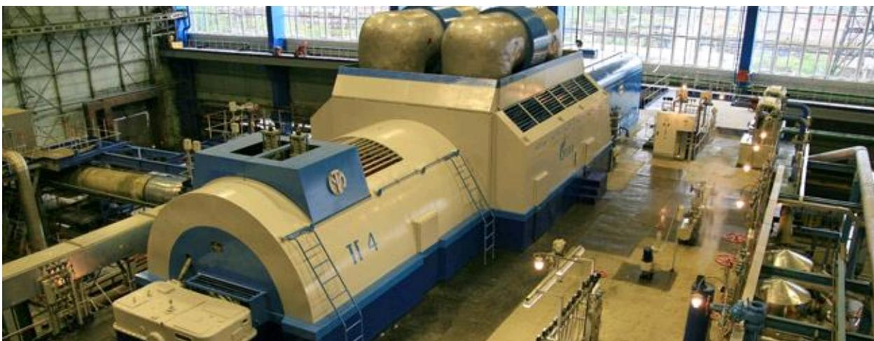
Рисунок 1 – Теплофикационная турбина
