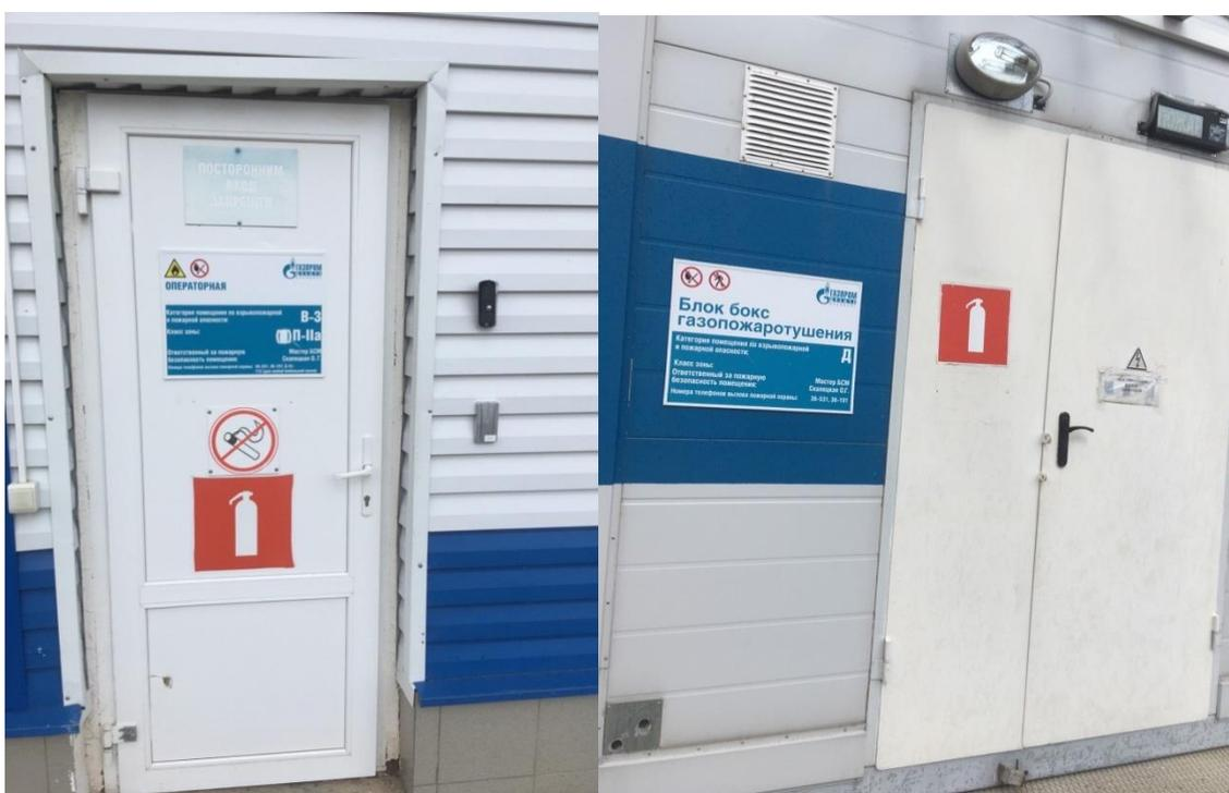
Рисунок 8 – Таблички с указанием категории помещения по взрывопожарной и пожарной опасности объекта
