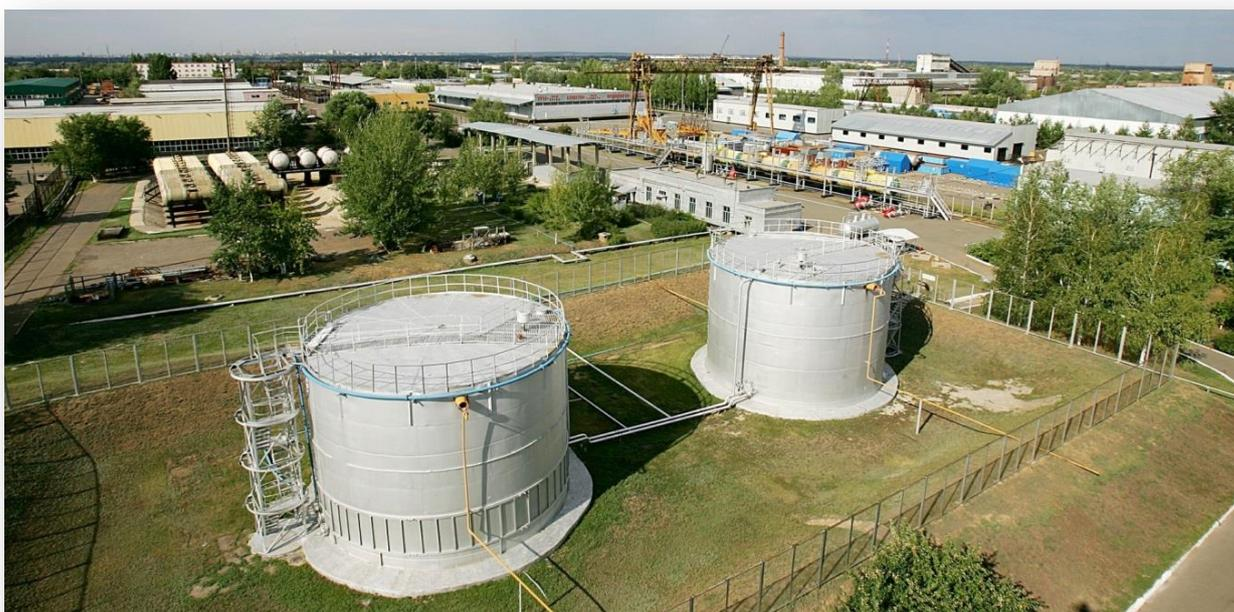
Рисунок 4 – Внешний вид резервуаров РВС-1000, расположенных УХиР МиХ УМТСиК ООО «Газпром добыча Оренбург»
