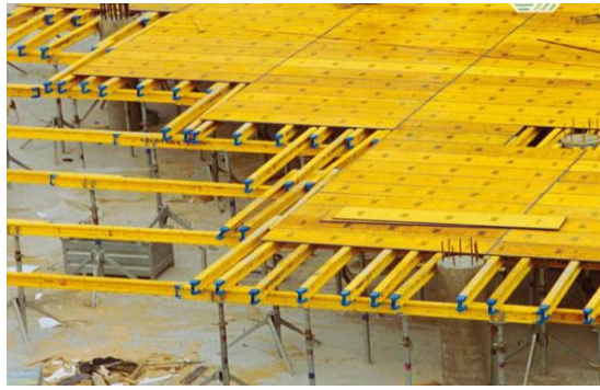
Рисунок 3.2 – Монтаж опалубки Dokaflex
