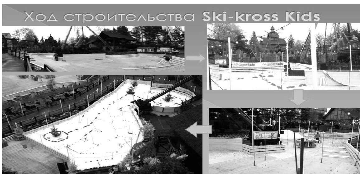
Рисунок Б.1 – Ход строительства детского лыжного городка
