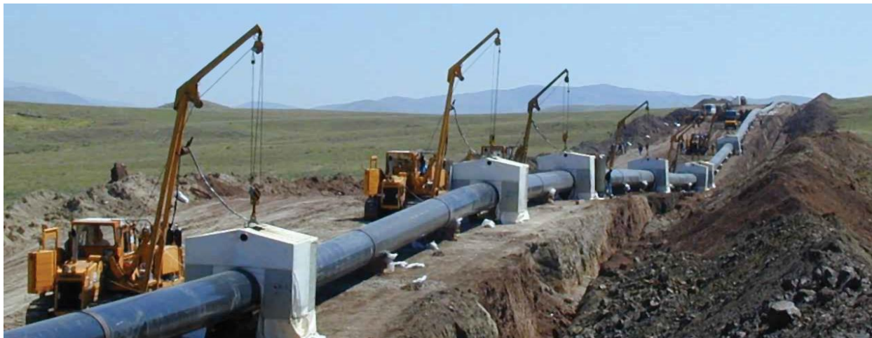
Рисунок 6 – Сварочный комплекс CRC-Evans
