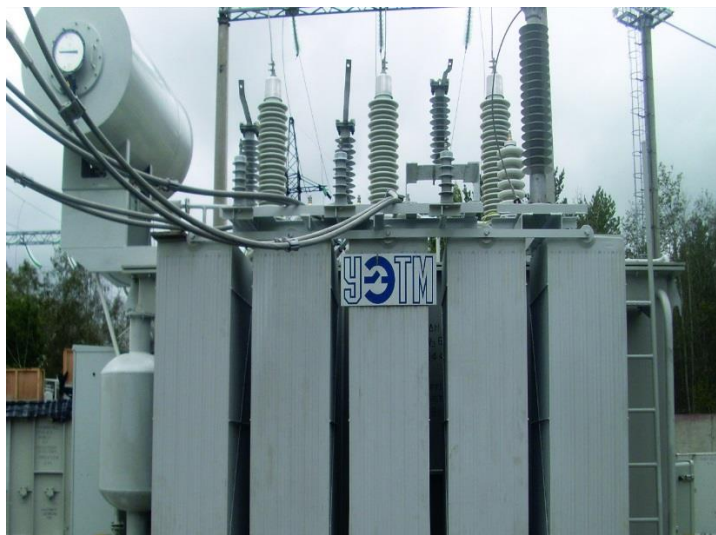
Рисунок 6 – Внешний вид ТРДН 40000/110/6,3/6,3 производства УЭТМ
