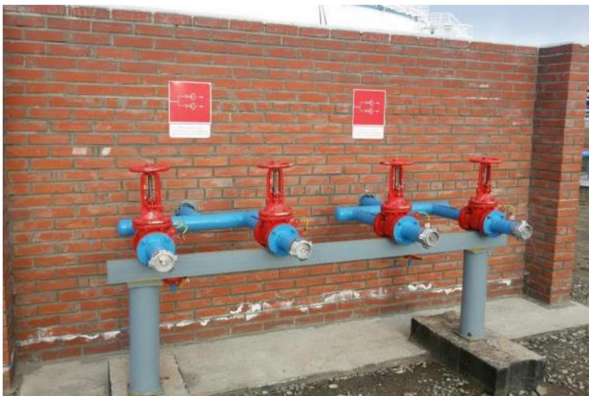
Рисунок 8 – Узел подключения водяного охлаждения ООО «Нова»
