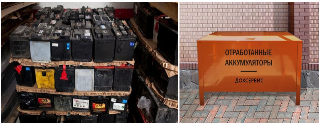
Рисунок 13 – Хранение отработанных аккумуляторных батарей до утилизации на складе предприятия или в специализированном контейнере
