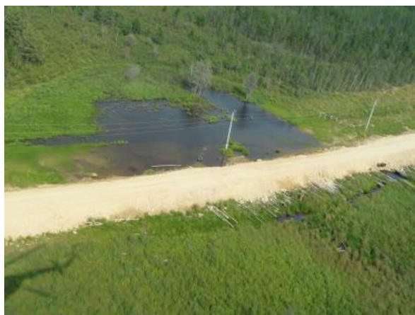
Рисунок 2 – Аэрокосмический снимок участка нефтепровода, проходящего через термокарст
