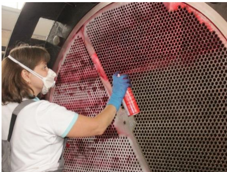
Рисунок 18 – Проведение цветной дефектоскопии при контроле качества сварки теплообменных узлов
