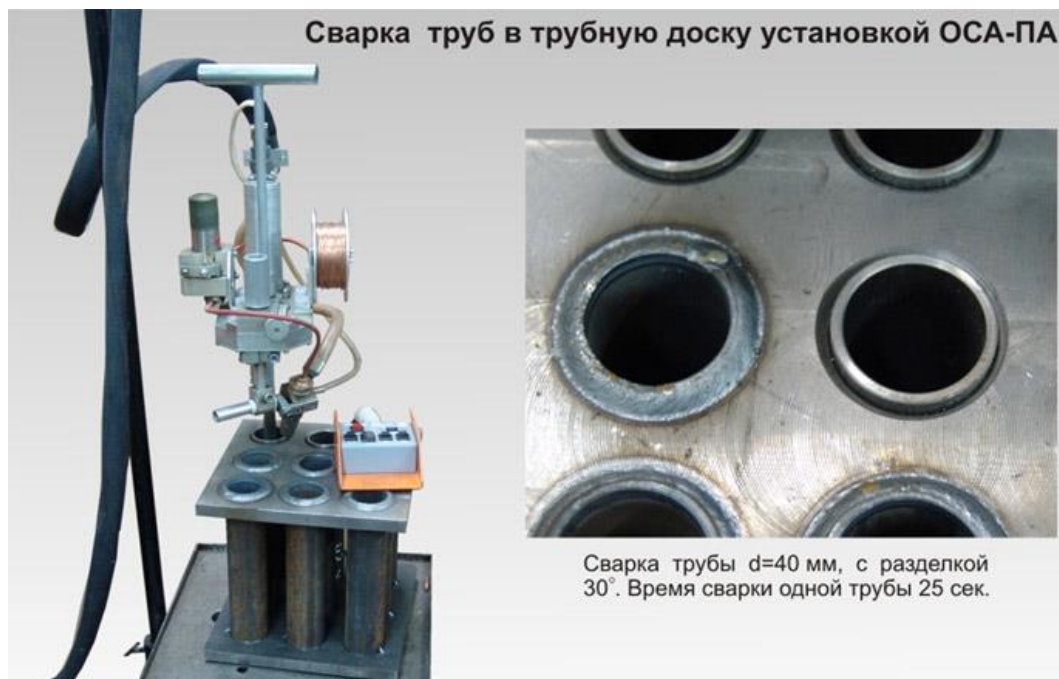
Рисунок 17 – Сварка труб на установке ОСА-ПА
