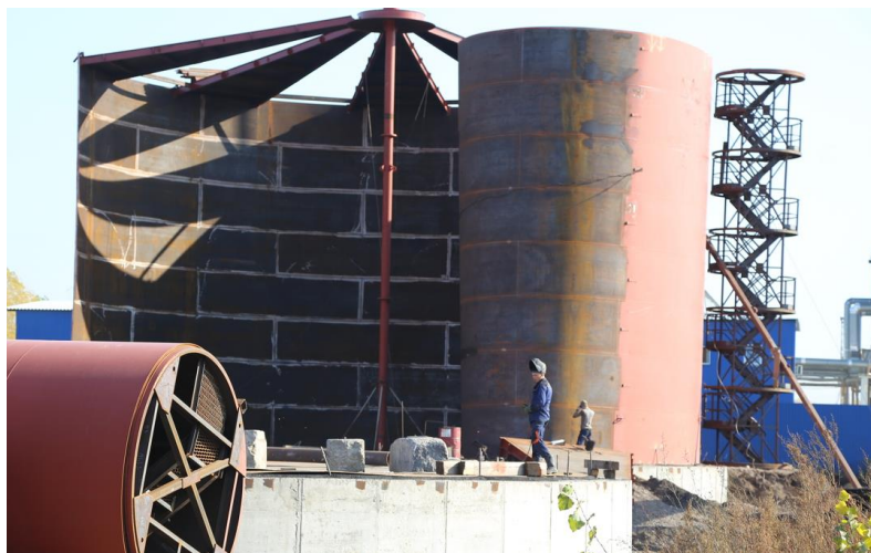
Рисунок 6 – Возведение резервуара рулонным методом
