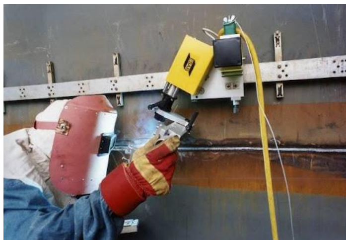
Рисунок 12 – Сварка горизонтального шва резервуара с использованием системы RailTrack 1000 (ESAB)
