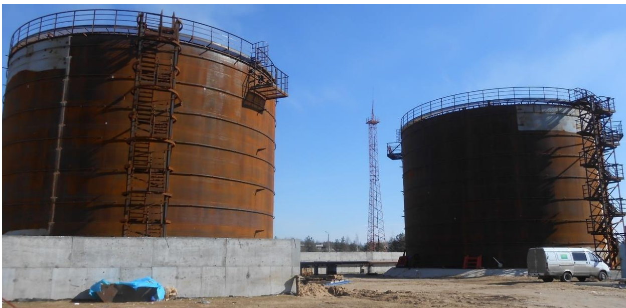
Рисунок 1 – Резервуар РВС-5000 для хранения нефти
