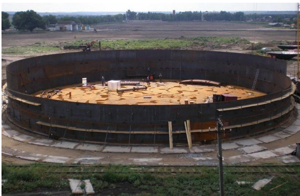
Рисунок 4 – Возведение резервуара методом наращивания
