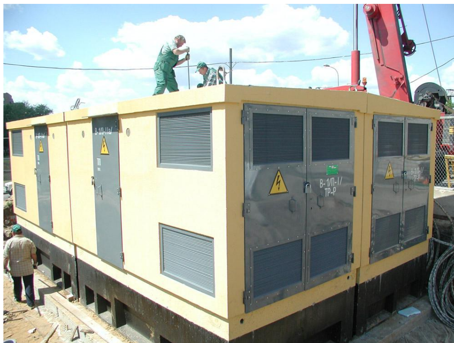
Рисунок 7.1 – Монтаж КТП
