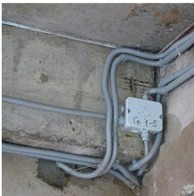
Рисунок 7.5 – Прокладка кабеля в стене
