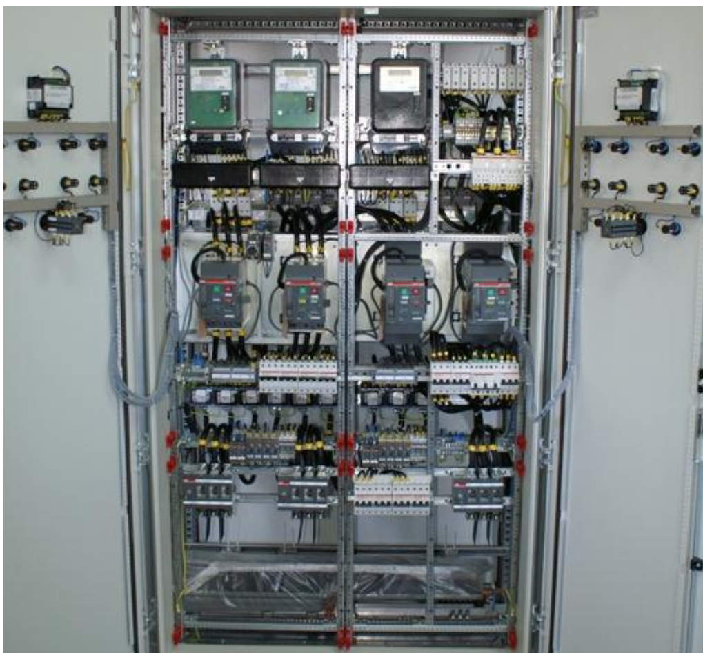
Рисунок 7.6 – Монтаж электрощитовой
