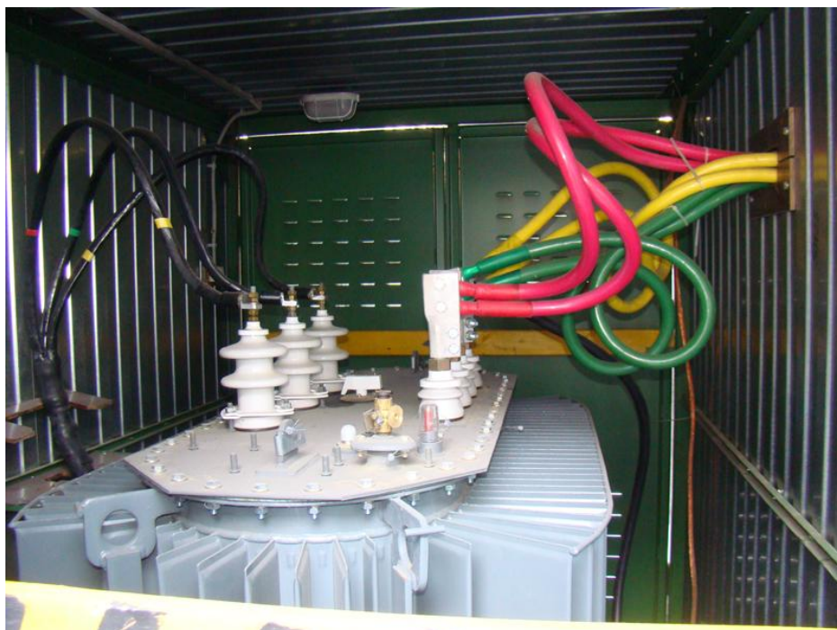
Рисунок 7.2 – Монтаж трансформатора
