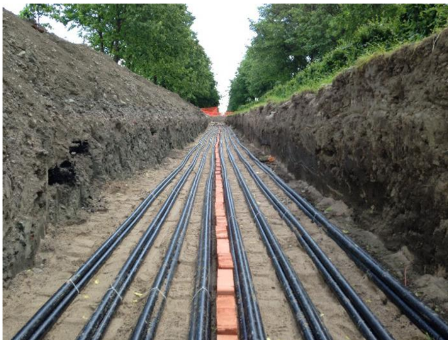
Рисунок 7.4 – Прокладка кабеля в траншее
