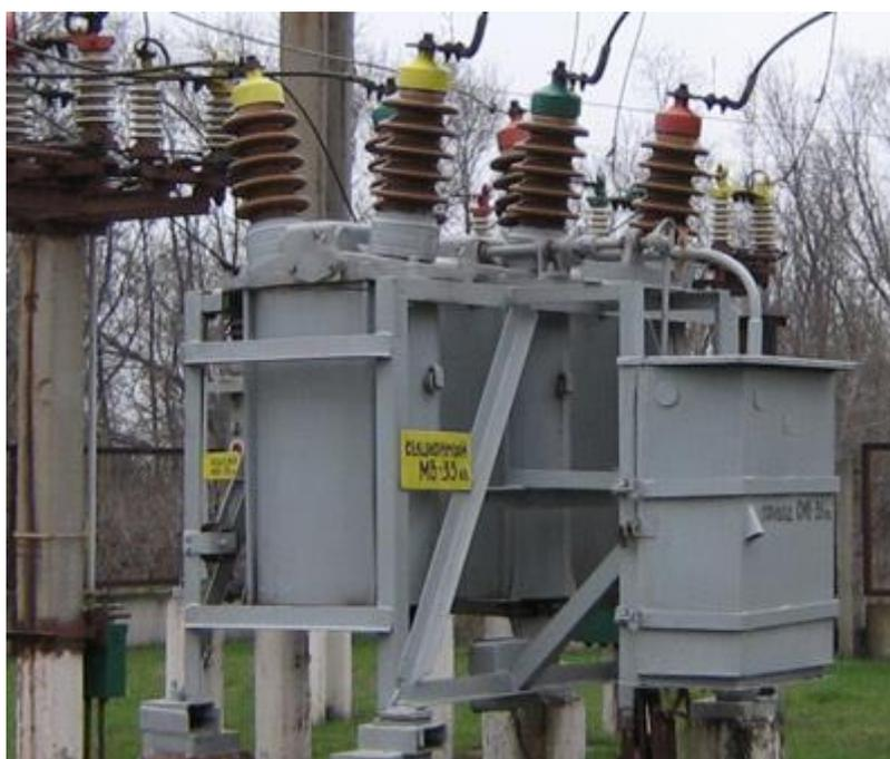
Рисунок 2 – Внешний вид выключателя С-35М-630-10АХЛ1
