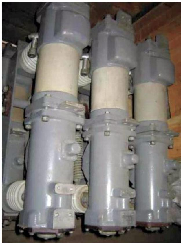
Рисунок 3 – Выключатель ВМГ – 10
