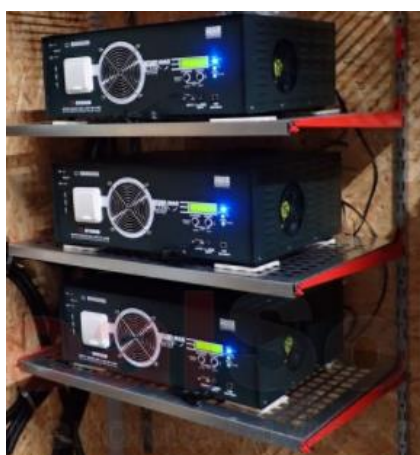
Рисунок 17– Контроллер заряда аккумуляторов от солнечных панелей МАП DOMINATOR 48В 20кВт 3-х фазный (60 кВт) т.м. Микроарт
