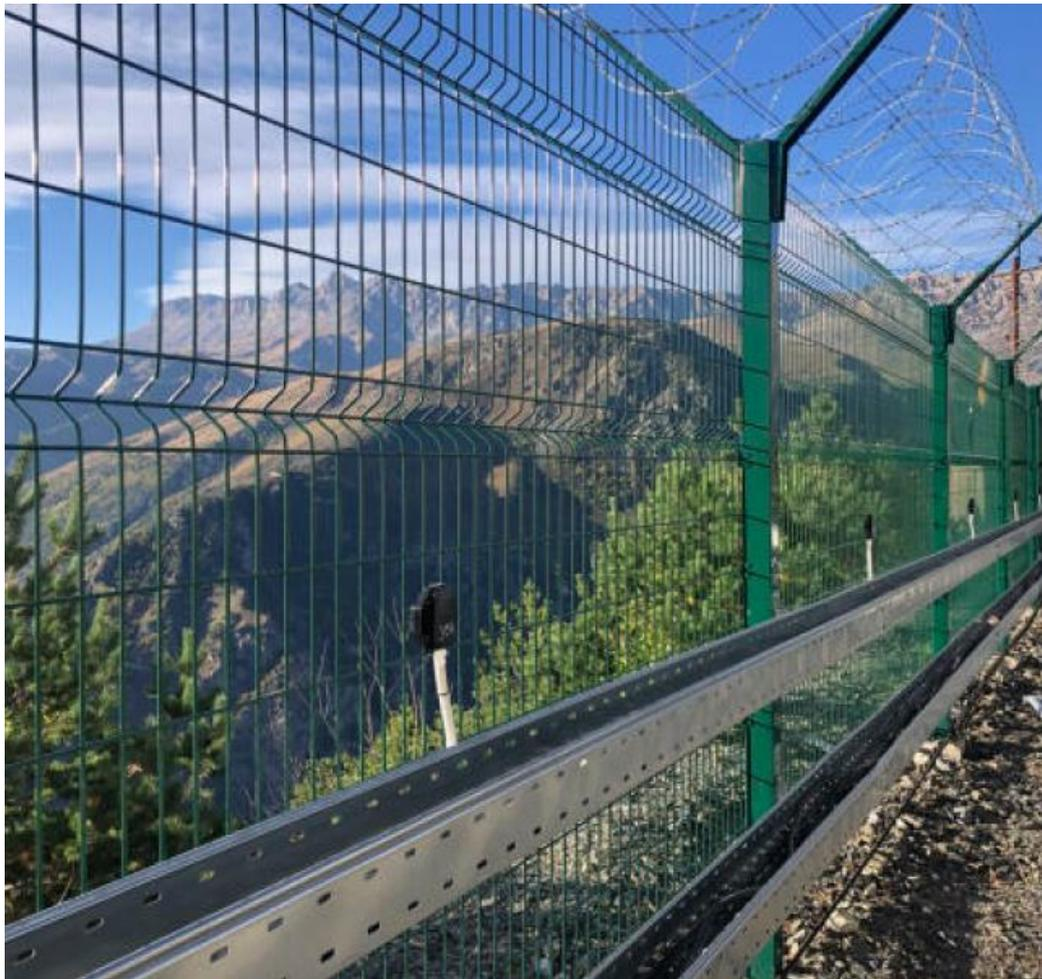
Рисунок 15 - Пример расположения датчиков на основном защитном ограждении
