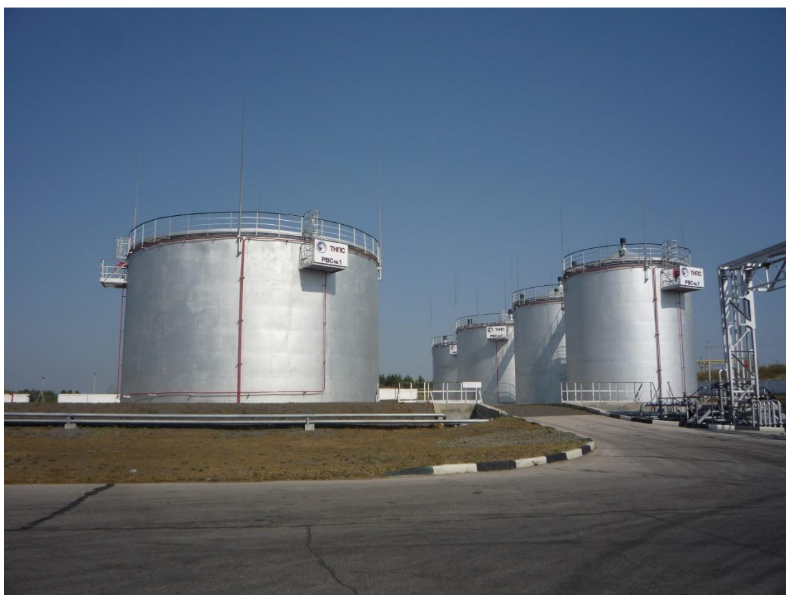
Рисунок 3 – Фото резервуарного парка
