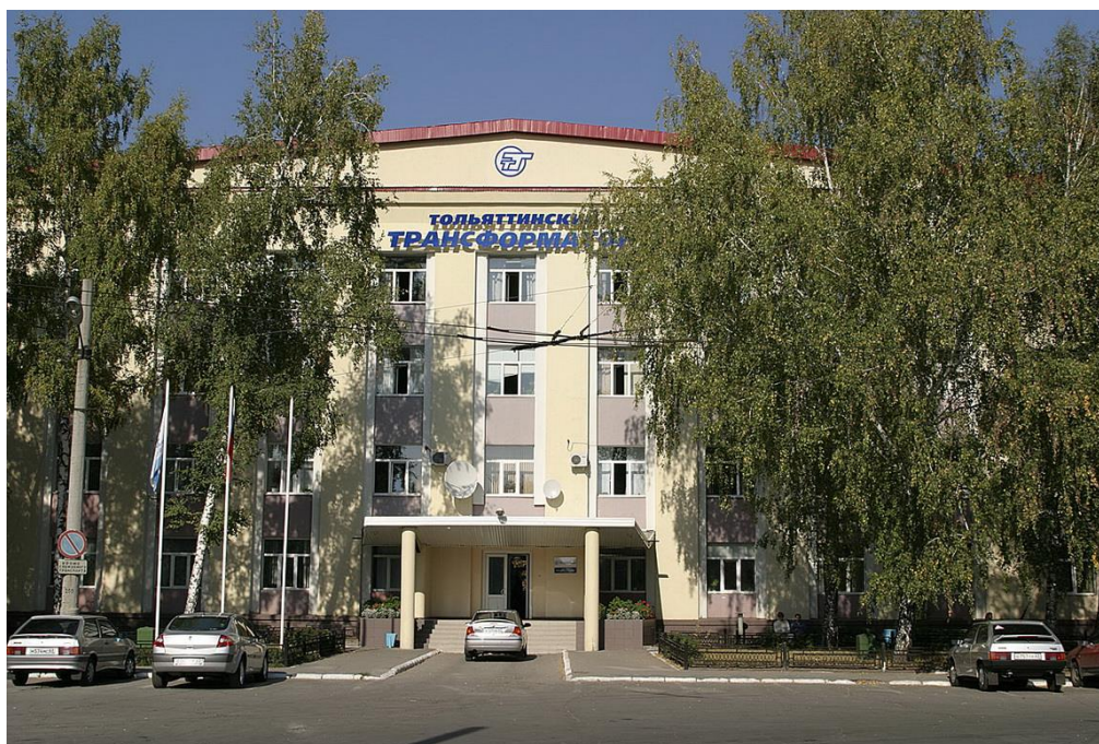
Рисунок 1 – Здание заводоуправления ООО «Тольяттинский трансформатор»
