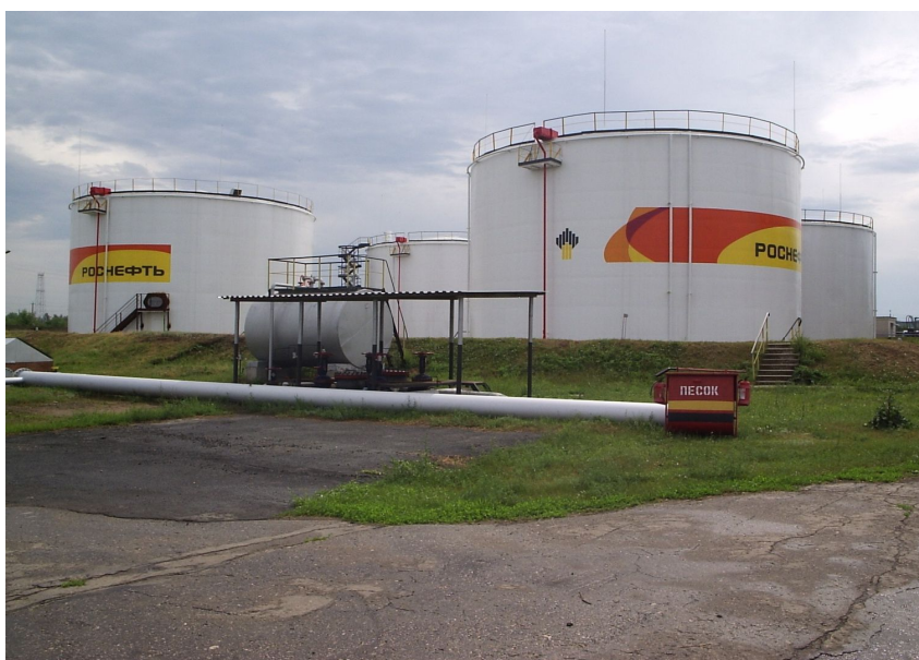
Рисунок 1 – Резервуары для хранения нефти
