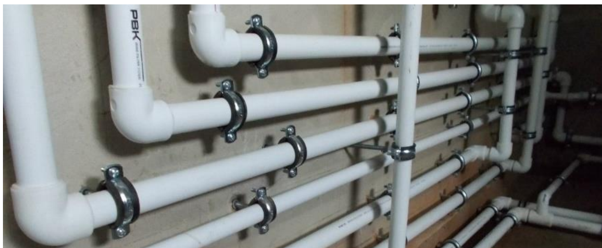
Рисунок 7 – Разводка трубопроводов из полипропилена
