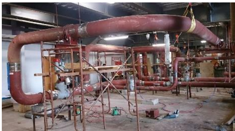
Рисунок 4 – Монтаж стальных трубопроводов (обвязка фильтров)
