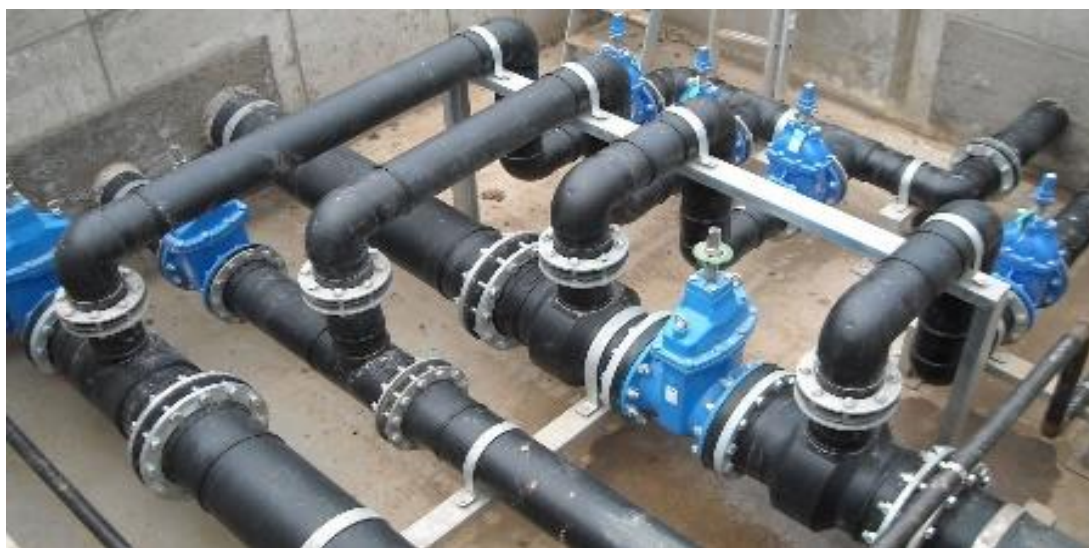
Рисунок 6 – Разводка трубопроводов из полиэтилена
