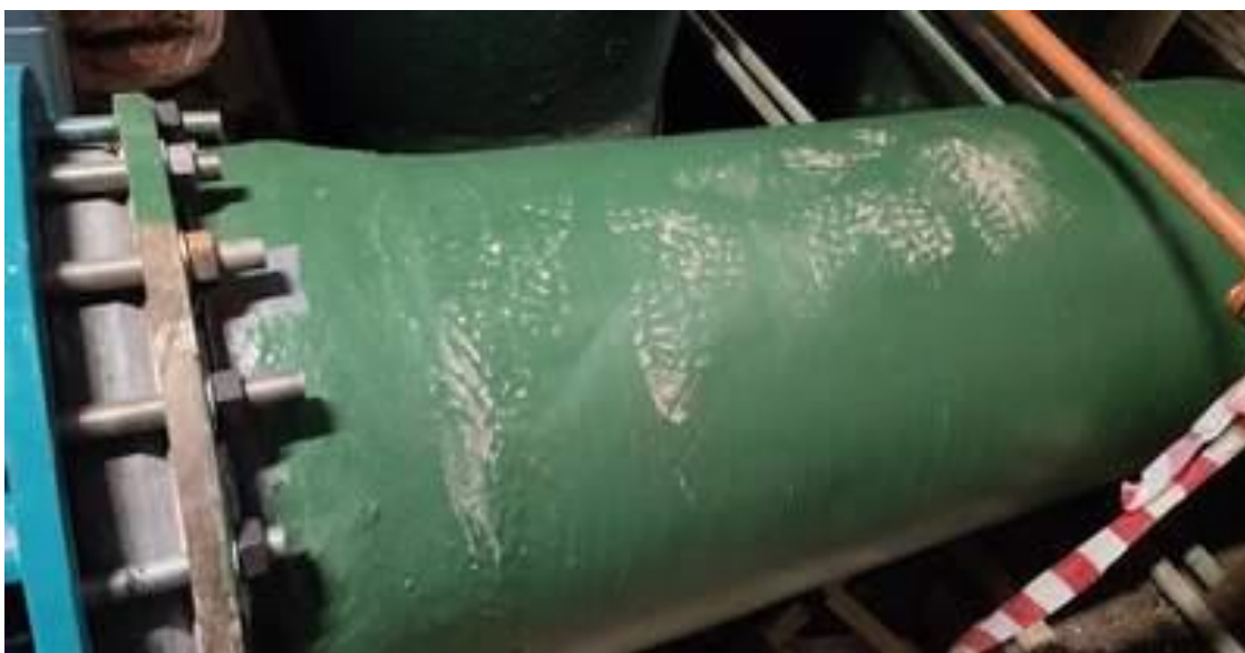
Рисунок 18 – Стыковка со стальными трубами
