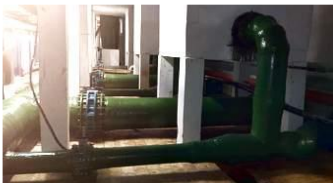
Рисунок 31 – Общий вид смонтированных трубопроводов
