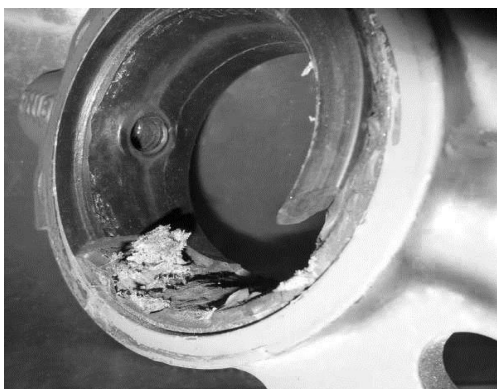
Рисунок 54 – Разрушение уплотнителя затвора
