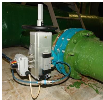
Рисунок 59 – Пневмопривод DAPS-CS1565588A для затвора d_y=250 мм
