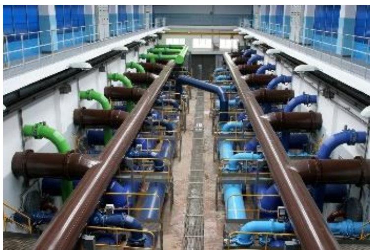
Рисунок 3 – Разводка стальных трубопроводов на очистных водозаборных сооружениях
