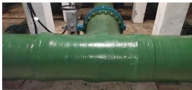
Рисунок 35 – Тройник и запорная арматура
