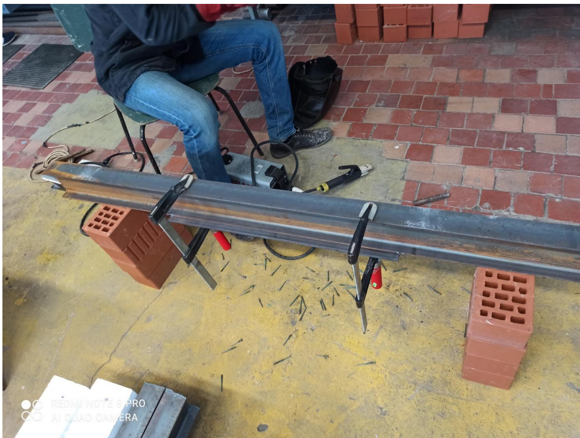
Рисунок 40– Прикрепление полосы - 100x10 к нижнему поясу испытываемой балки Б2
