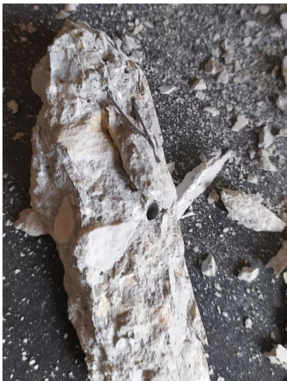
Рисунок 13 – Состояние фибры в бетоне после разрушения образца
