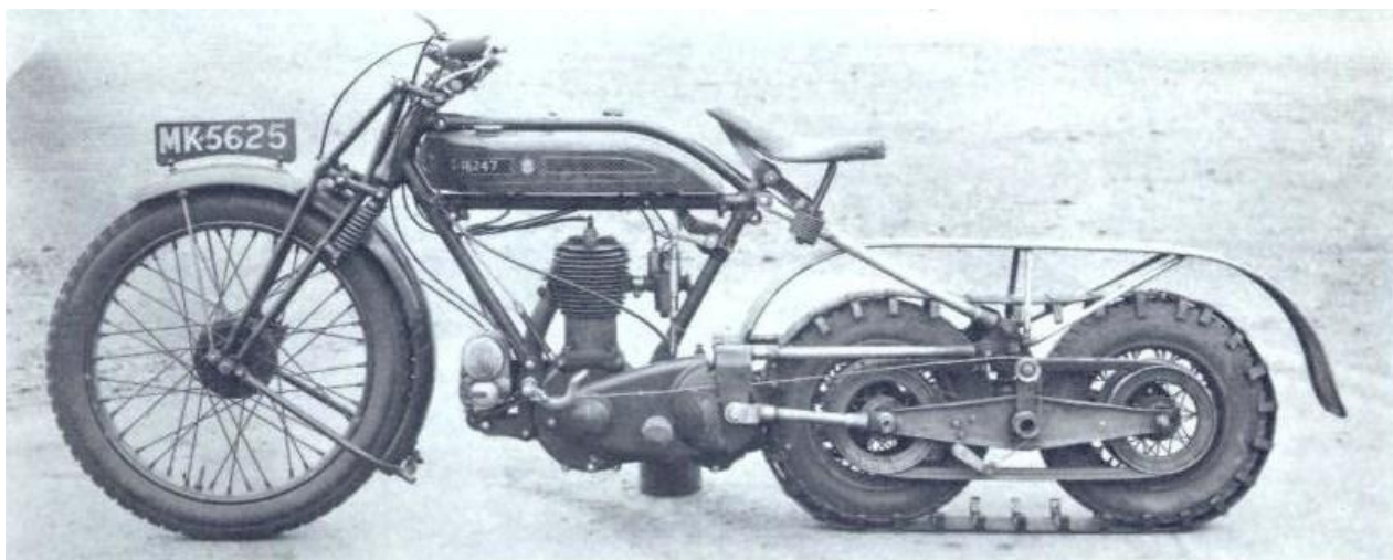
Рисунок 2 – RASC Triumph гусеничный мотоцикл, 1927
