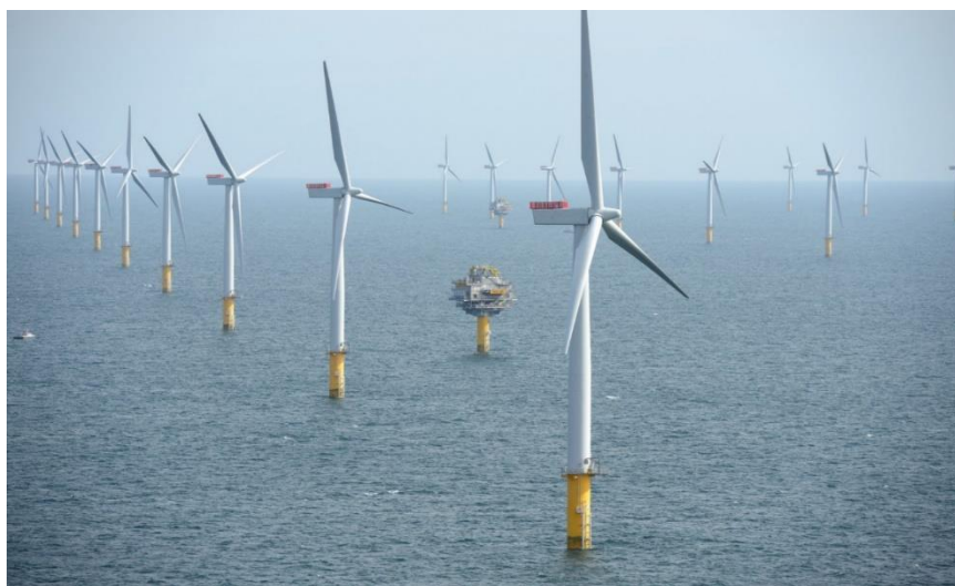
Рисунок 1.3 - Шельфовая электростанция Sheringham Shoal, Великобритания
