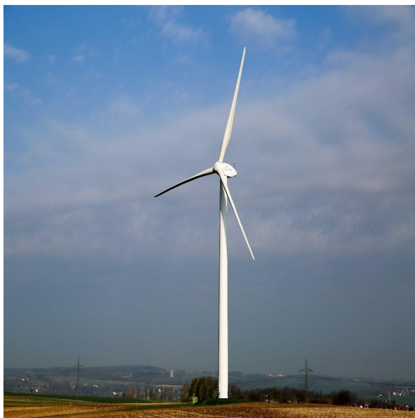
Рисунок 1.2.4 – Модель трёхлопастного ветрогенератора Enercon e-126 мощностью 7,58 МВт
