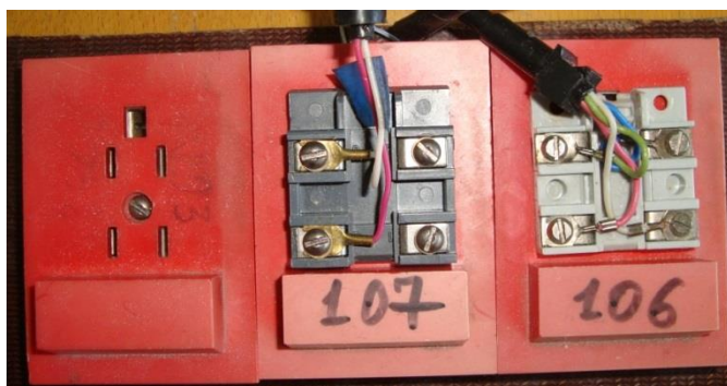
Рисунок 3.5 – Подключение к телефонной линии
