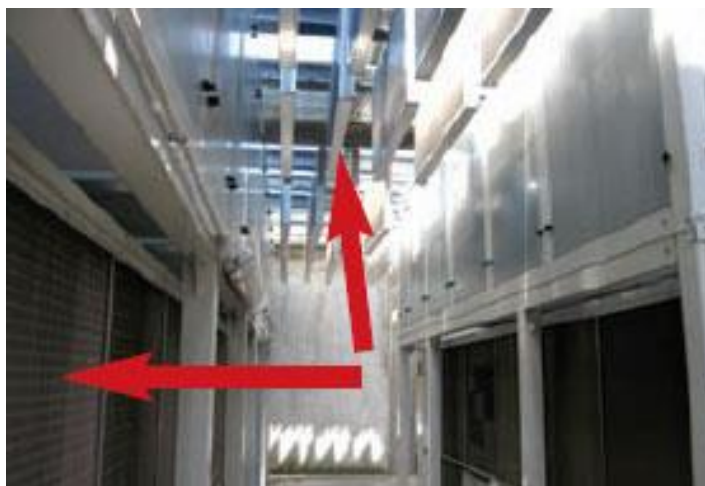
Рисунок 2.5 – Шумозащитные экраны в помещении хладоцентра
