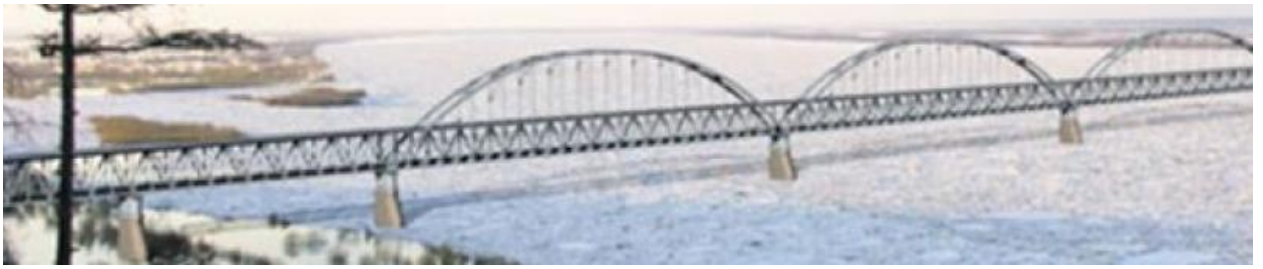
Рисунок 1 – Общий вид моста
