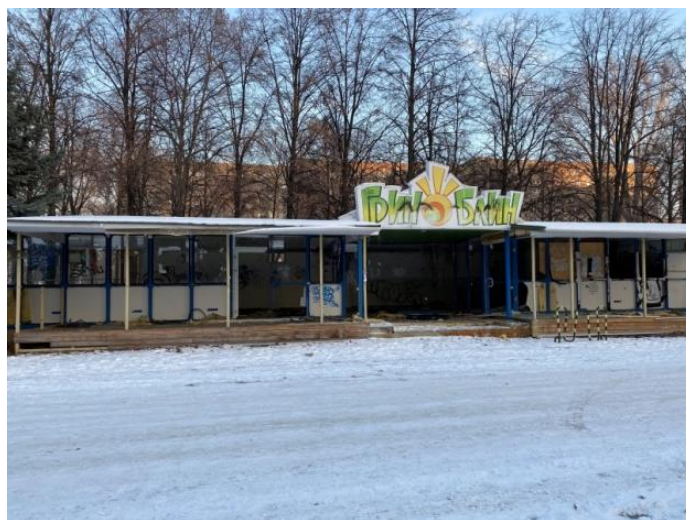
Рисунок А.20 – Зброшенне помешчэнне
