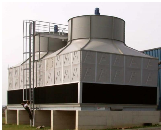
Рисунок 20 – Противоточная градирня
