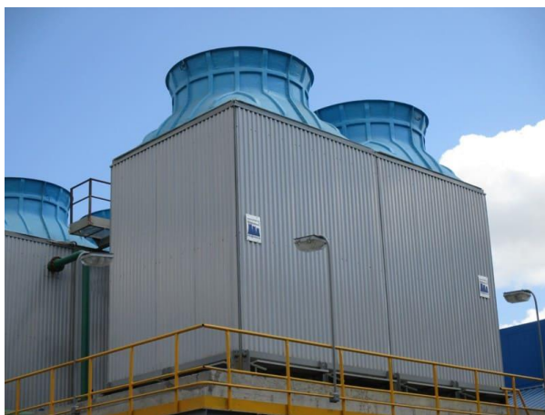
Рисунок 12 – Вентиляторная градирня
