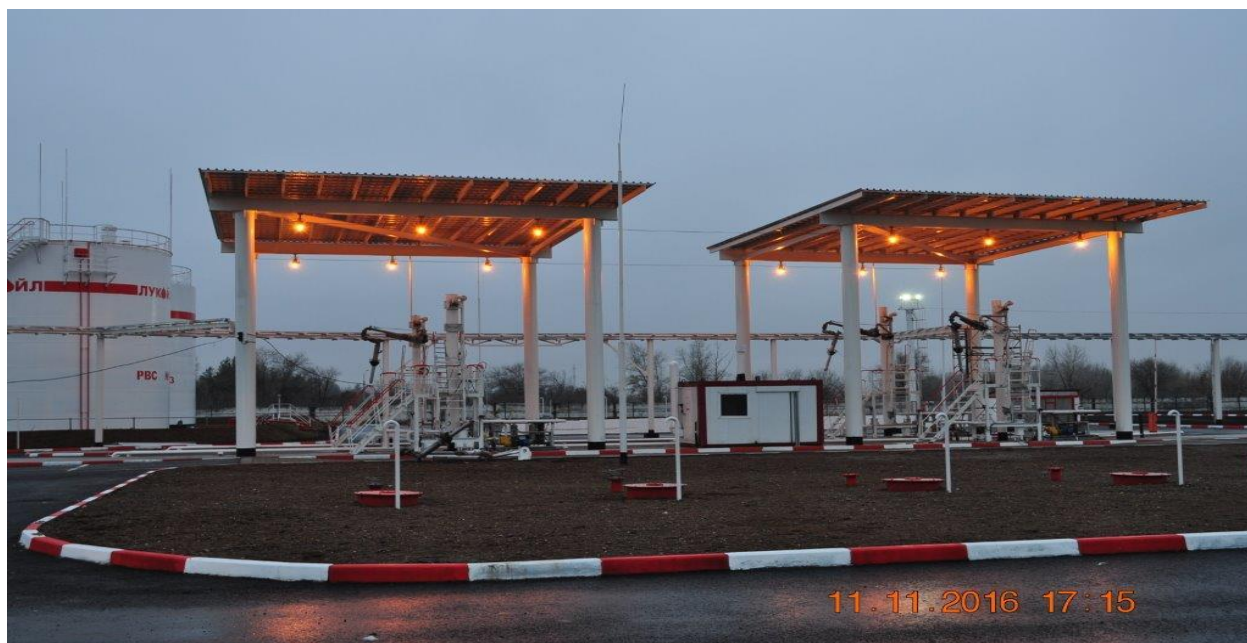
Рисунок 6 - Наливное устройство для автоцистерн
